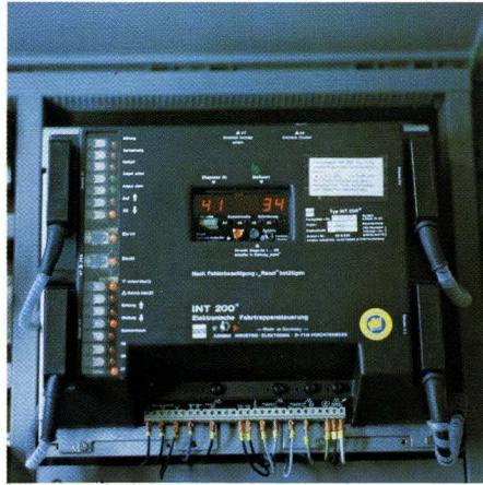
Die Steuerung einiger Fahrtreppen ist bereits in Mikroelektronik ausgeführt, die ein sanfteres Anlaufen bewirkt sowie Störungsursachen auswertet und für den Wartungsdienst speichert.
